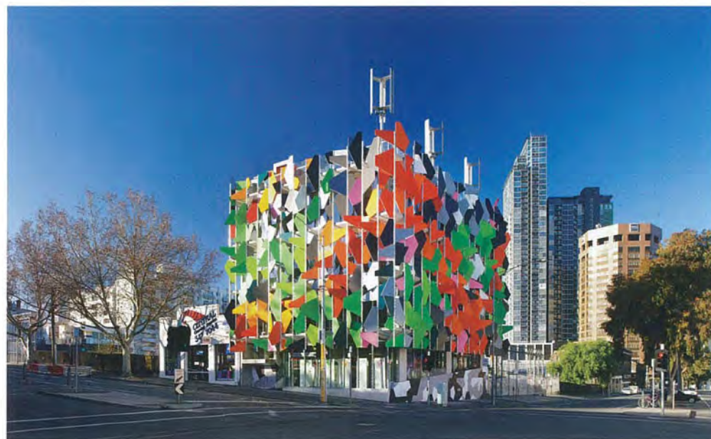
Das Pixel-Building ist mit LEED Platin zertifiziert
