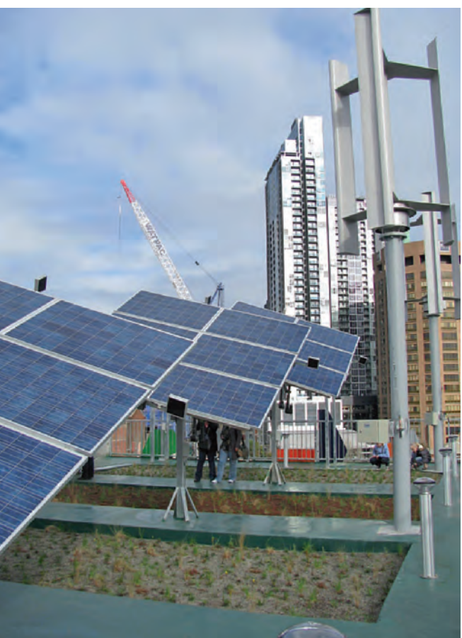
Il fabbisogno di energia elettrica dell'edificio è affidato a tre turbine eoliche, studiate appositamente per l'impiego in città, e a pannelli fotovoltaici, alcuni dei quali posti su strutture a inseguimento solare (foto Grocon Pty.).
