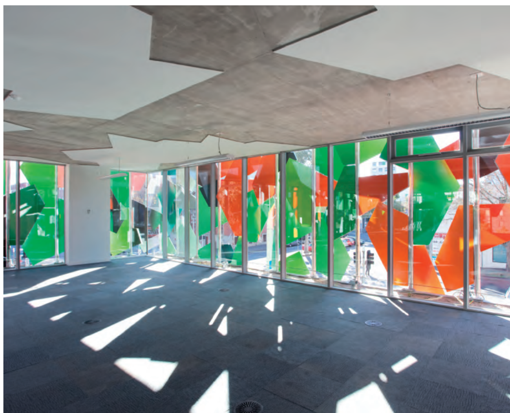
La facciata nord vista dall'open space interno: i soffitti svolgono il ruolo di superfici radianti, mentre i diffusori a pavimento provvedono all'immissione dell'aria in ambiente (foto Ben Hosking).
