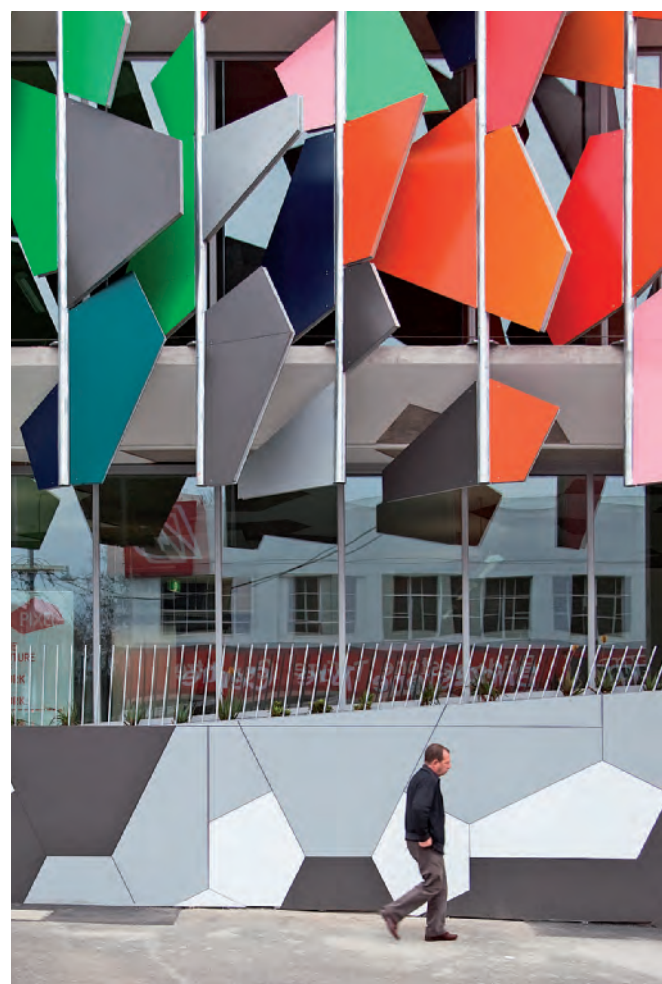
L'immagine architettonica di Pixel è caratterizzata dai pannelli colorati orientabili che, cambiando la propria posizione nel tempo, rappresentano le trasformazioni edilizie in atto nel lotto retrostante (foto Ben Hosking).
